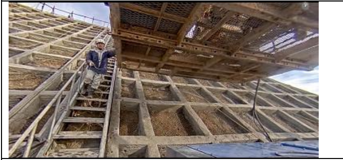
写真-7 リスク着眼点での作業内容(機材吊り込み作業)
